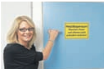
◆ Selten im Heizkeller, denn die Anlage ist praktisch wartungsfrei
